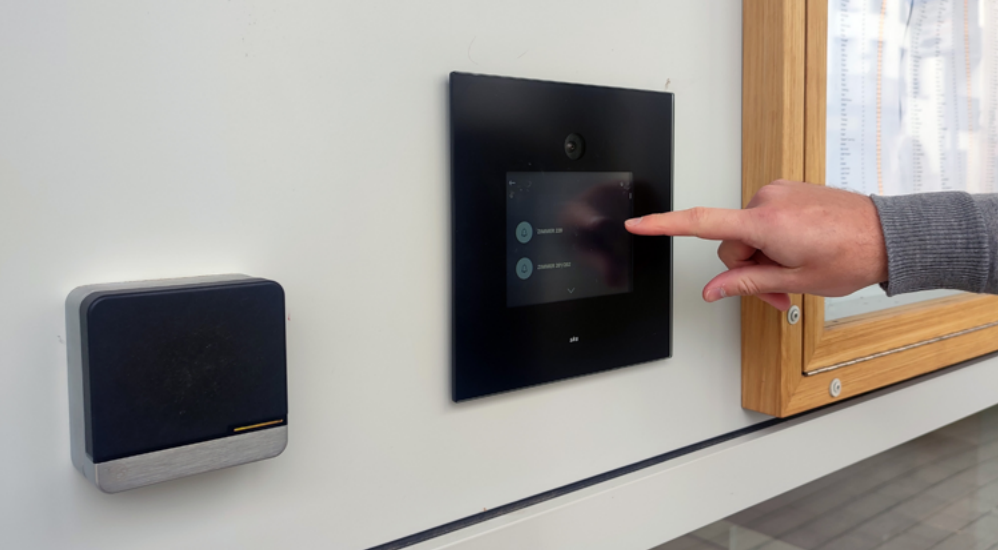
Celui qui possède un badge obtient l'accès via le « Updater » (à gauche) qui vérifie le droit d'accès et libère la porte. Tous les autres s'inscrivent sur le tableau de sonnettes (à droite). © CES
